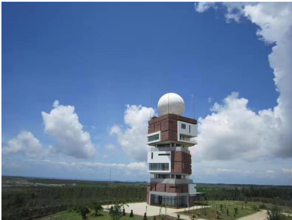
图 4.1-4 湛江新一代天气雷达站现场照片
