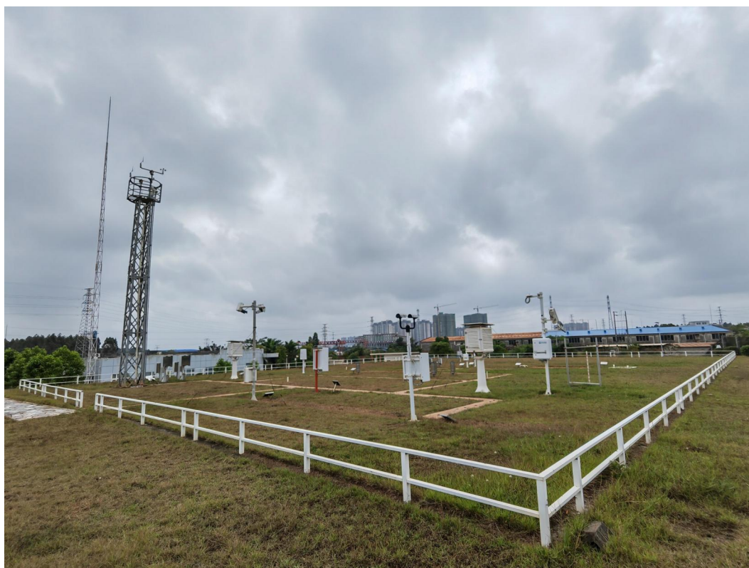
图 4.1-2 气象站现场照片
